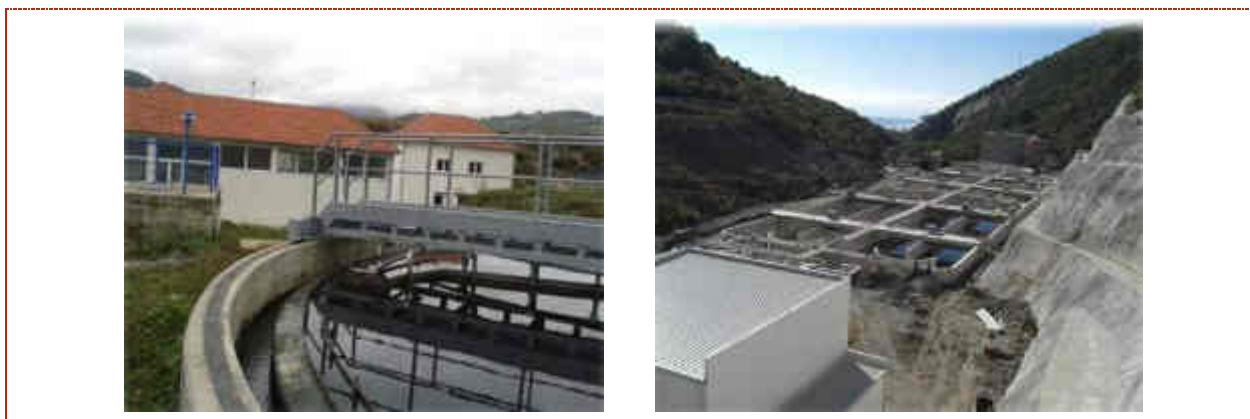
Abbildung 5.24: Kläranlage Mjkovac (links) und Kläranlage Budva (rechts)
